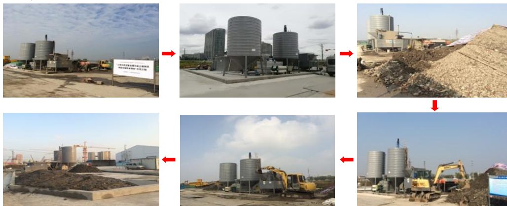
图 2 淋洗修复过程现场图
